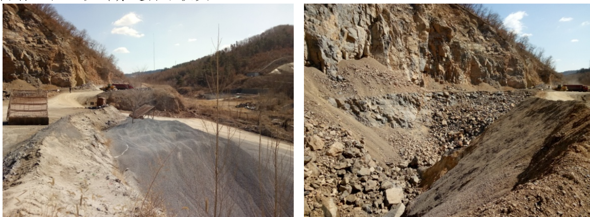
矿山现场调查照片
