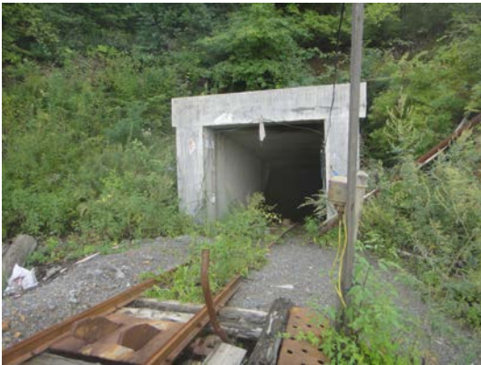
矿区采坑主井
