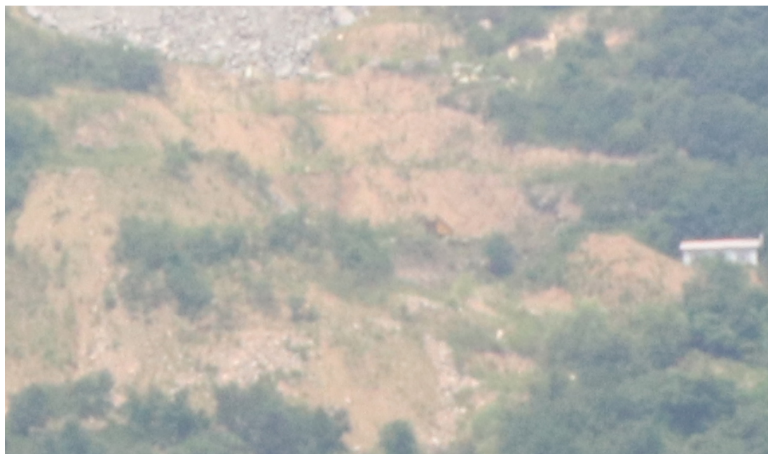
照片 2-8 表土堆放场 1
