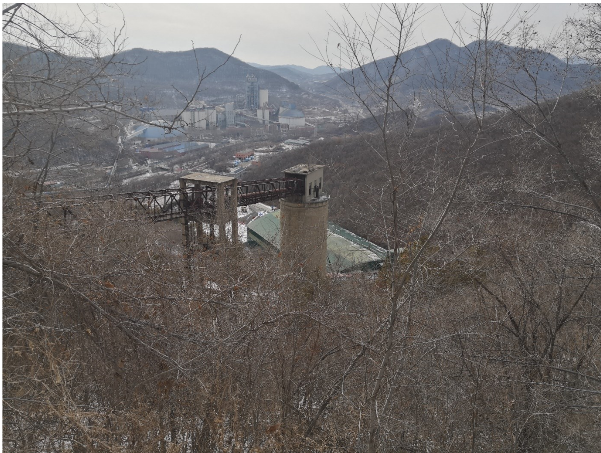
照片 3-2 工业场地现状
