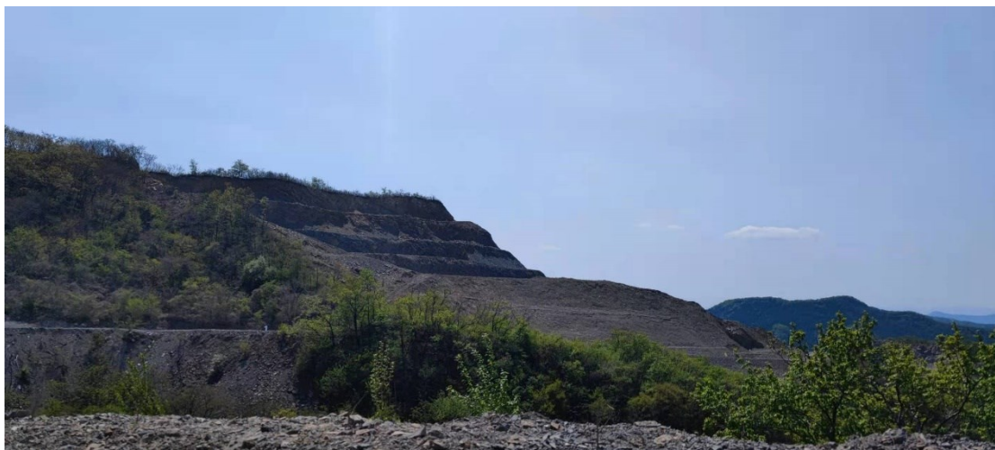
照片 2-6 案例 1 矿山恢复治理效果（边坡削坡平整、植被恢复）
