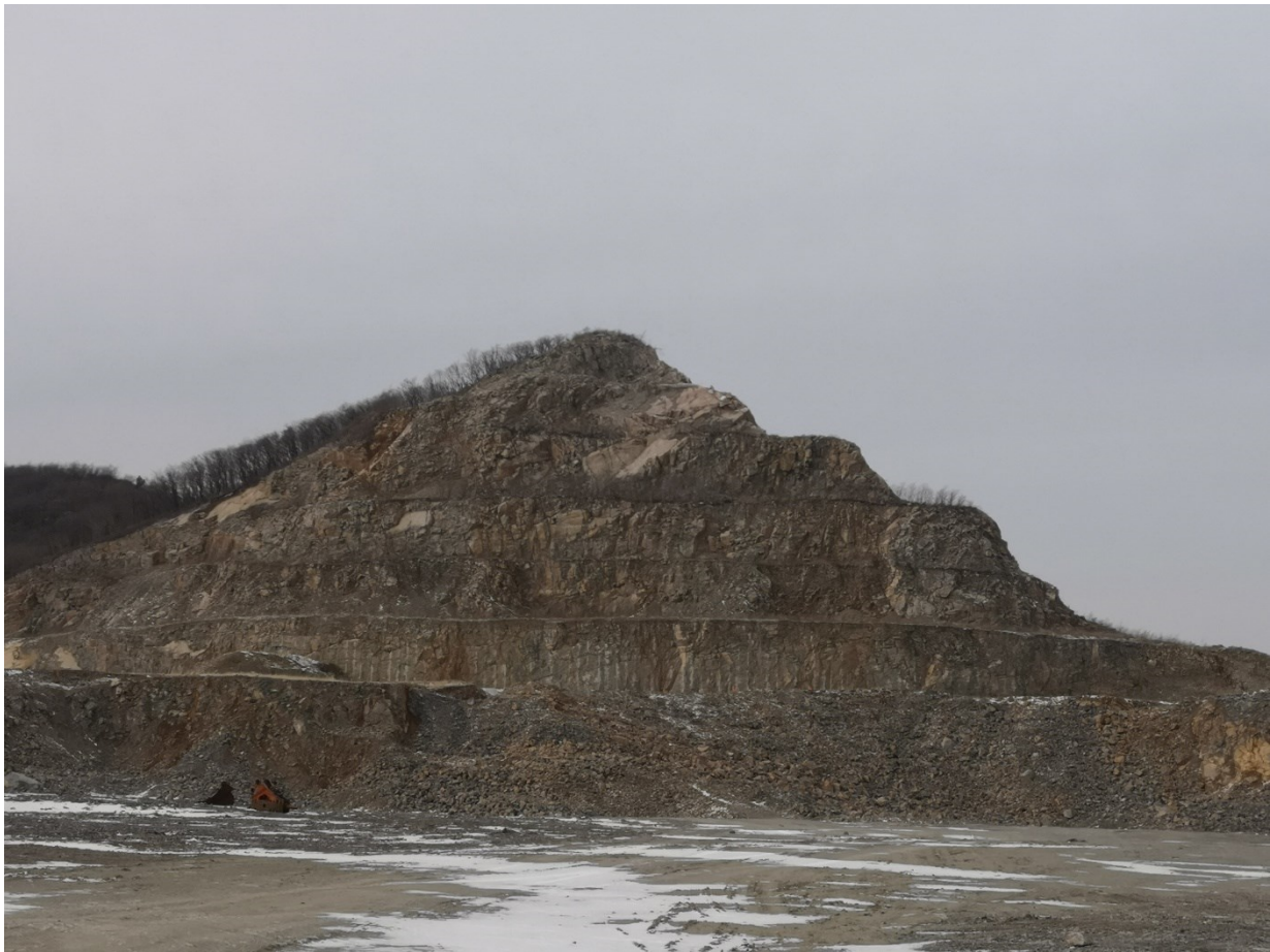
照片 3-1 不稳定边坡
