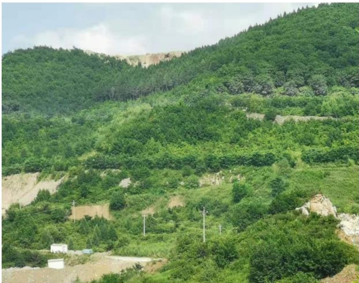
图 2-5 本溪钢铁（集团）矿业闫家沟石灰石矿有限公司治理情况
