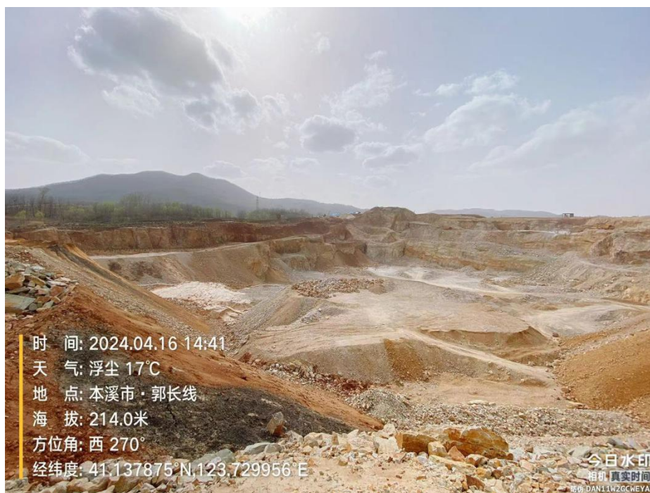
照片 3-1 露天采场现状
