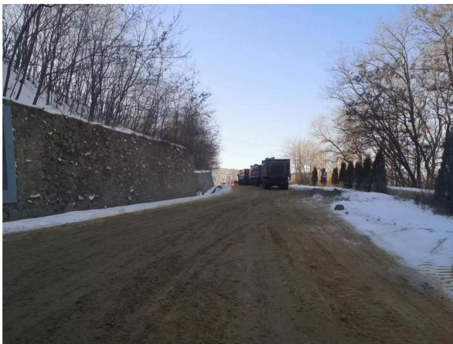
照片 3-5 矿山道路现状
