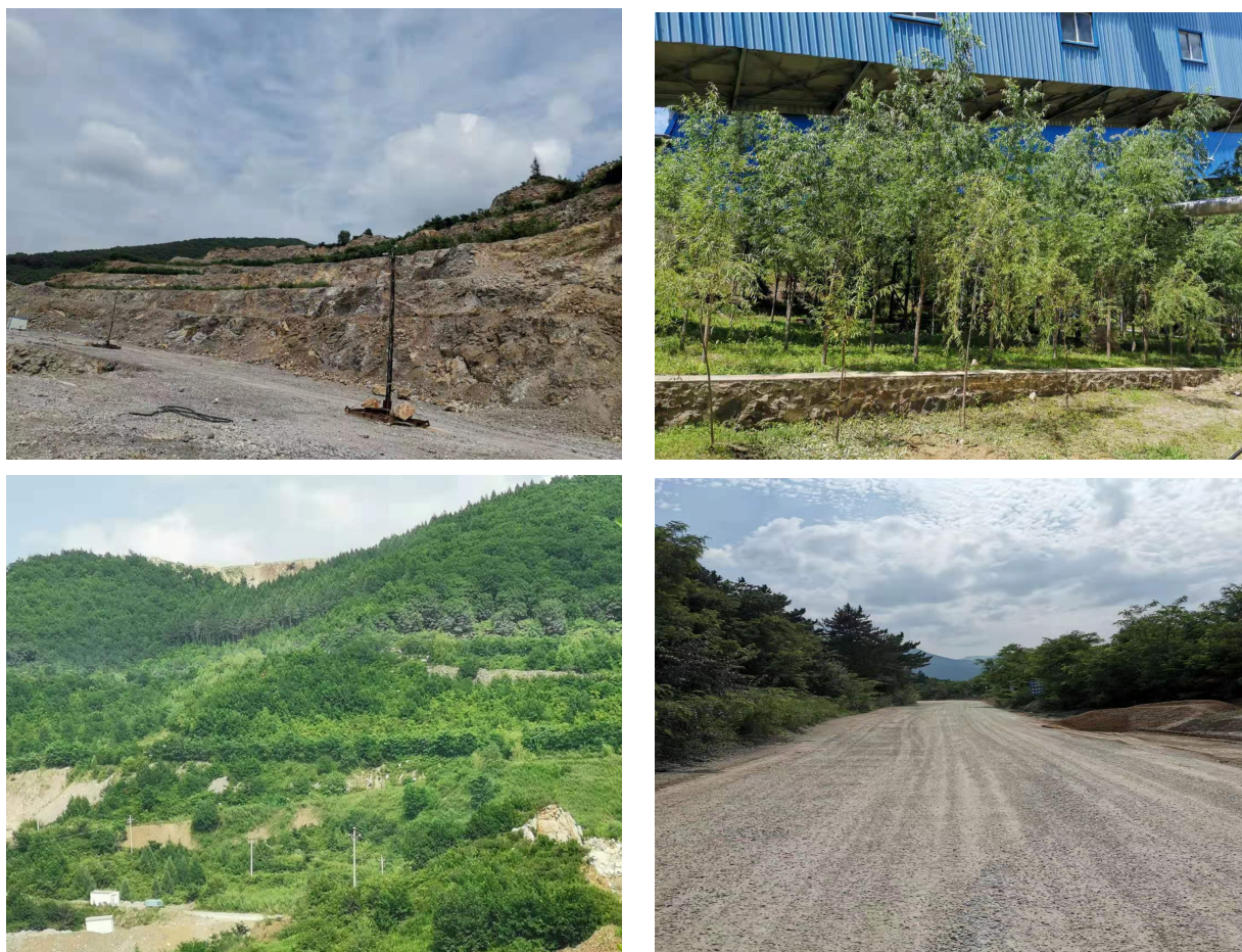
图 2-10 本溪钢铁（集团）矿业闫家沟石灰石矿有限公司治理情况
