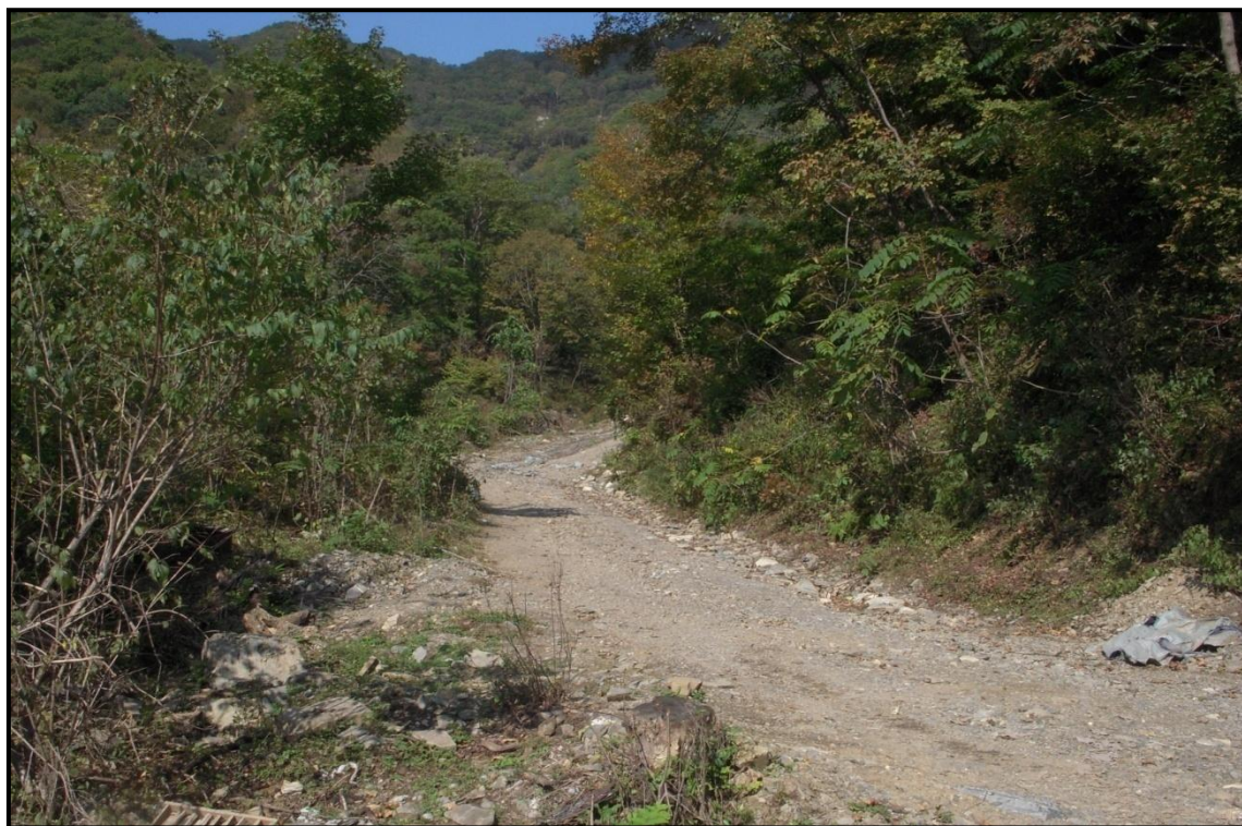
照片 3-6 临时运输道路
