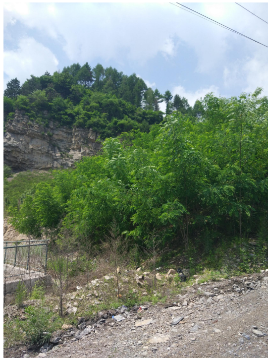
照片 2-5 本溪县田师付镇腰堡破损山体治理工程治理后效果
